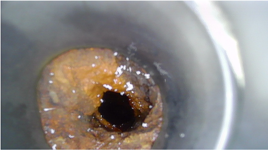
流し台排水管内部
