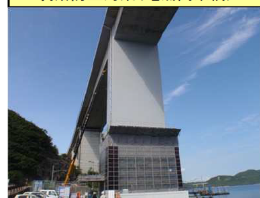
剥落防止対策(亀浦高架橋)
