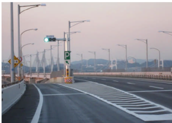
現況の与島パーキングエリア(上り線)分岐部
