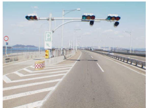
一時撤去する前の与島パーキングエリア(上り線)分岐部
