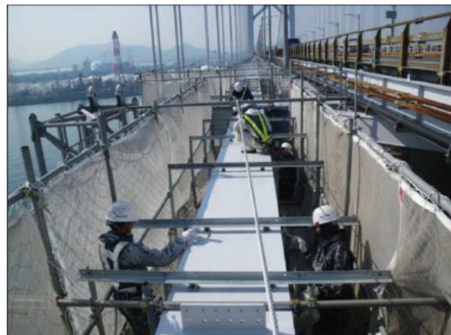
長大橋塗替塗装(瀬戸大橋)
