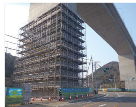
剥落防止対策(亀浦高架橋)
