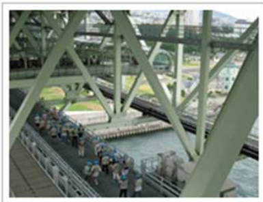
明石海峡大橋の橋桁の中を約1km歩いて主塔へ。
