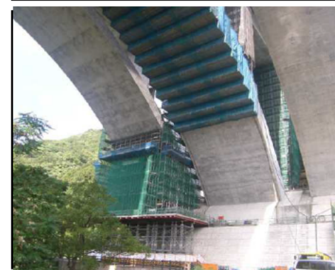
耐震補強(茶間川橋)
