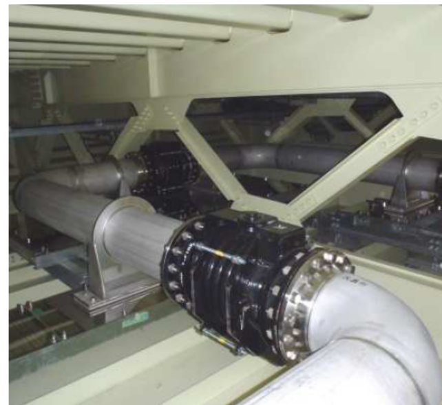
来島海峡大橋送水管添架工事
