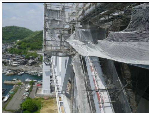
長大橋塗替塗装(瀬戸大橋)
