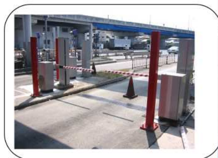
【一般レーンへのバー設置】
