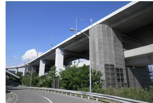
耐震補強(櫃石島高架橋)
