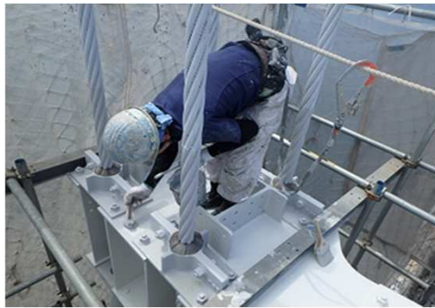
長大橋塗替塗装(瀬戸大橋)
