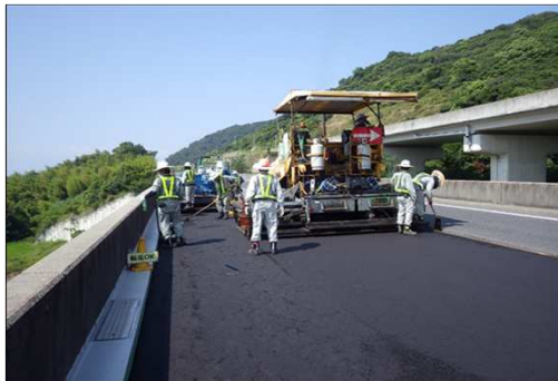
舗装補修(神戸淡路鳴門自動車道)
