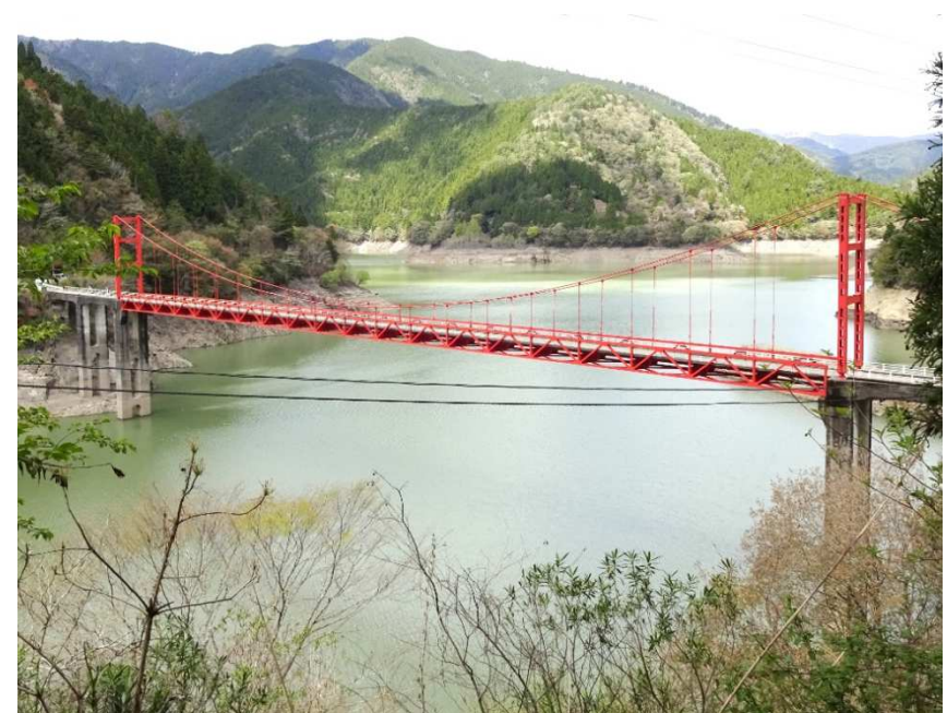
魚梁瀬大橋(高知県)技術支援業務(耐震検討等)
