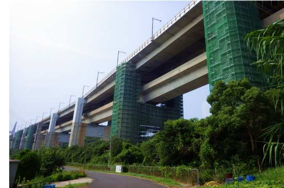
耐震補強(瀬戸中央自動車道)
