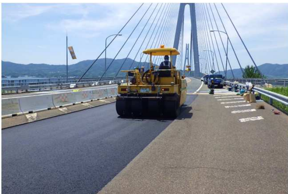
舗装補修(西瀬戸自動車道)
