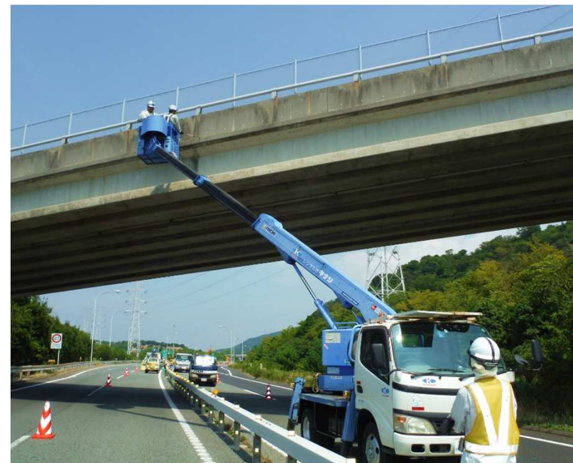
跨道橋点検(兵庫県受託)
