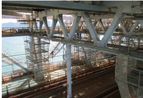
長大橋塗替塗装(瀬戸大橋)
