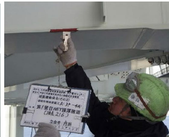
第1層目WET膜厚確認
