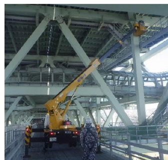
高所作業車による施工例
