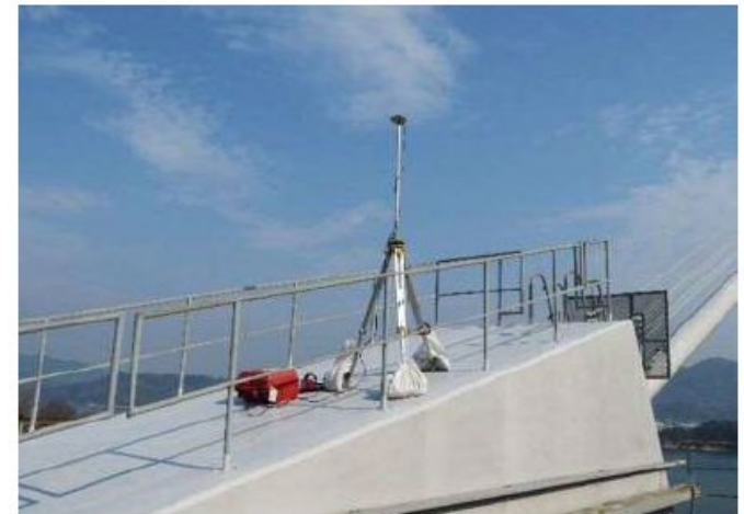
複数の衛星による測量（GNSS測量）
