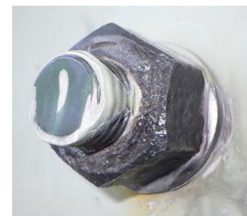
HTボルト素地調整の程度
