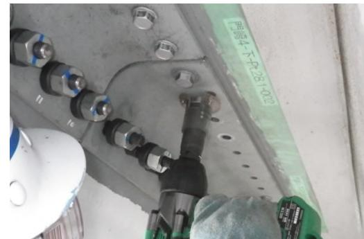
TRS<sup>\*</sup>を用いた鋼床版疲労亀裂の補修
