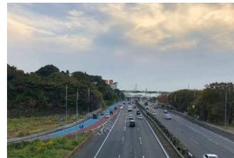
合流部の渋滞緩和のため横浜町田ICの加速車線を延伸しました。さらに、2車線ランプを分離型としスムーズな加速が可能とするためカラー舗装を実施しました。
