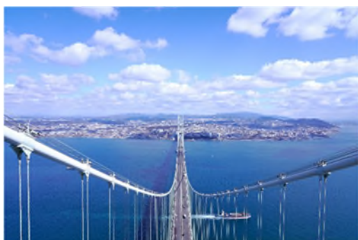
淡路島側主塔塔頂より神戸方面を望む
