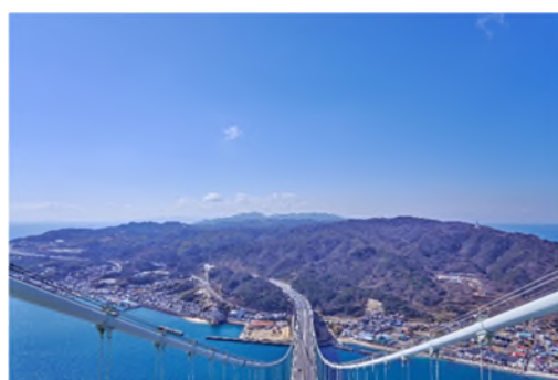
淡路島側主塔塔頂より淡路島方面を望む
