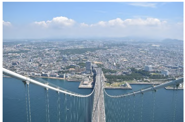
神戸側主塔(2P)からの風景（神戸側を望む）
