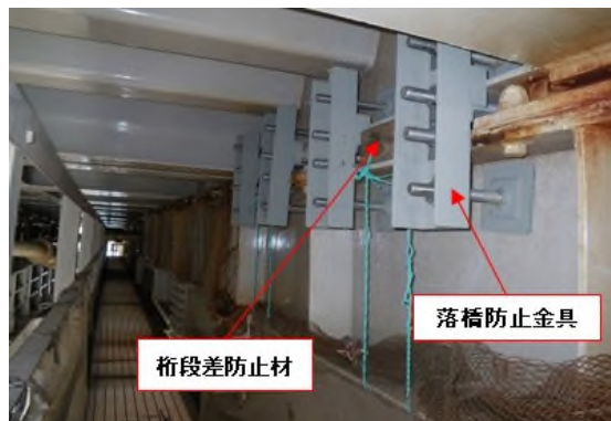
② 落橋防止金具による応急措置状況
