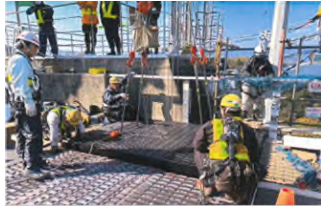
④新規大型伸縮装置設置状況
