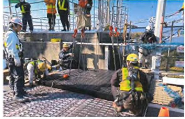
④新規大型伸縮装置設置状況
