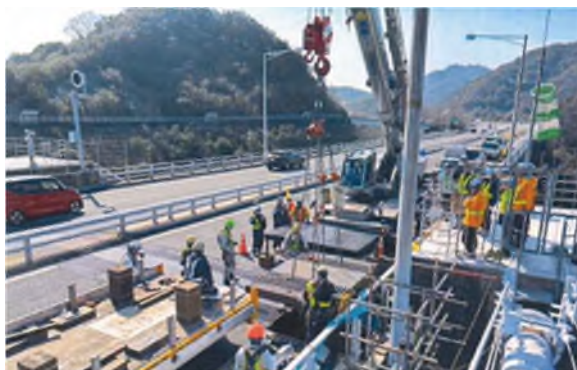
③ 既設大型伸縮装置撤去状況
