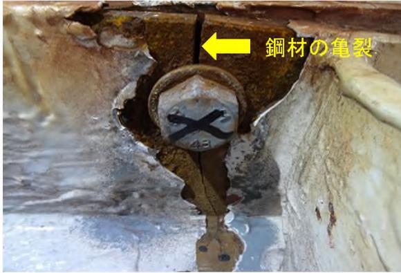
①伸縮装置の腐食状況（路面裏側）
