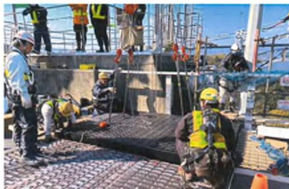
④ 新規大型伸縮装置設置状況
