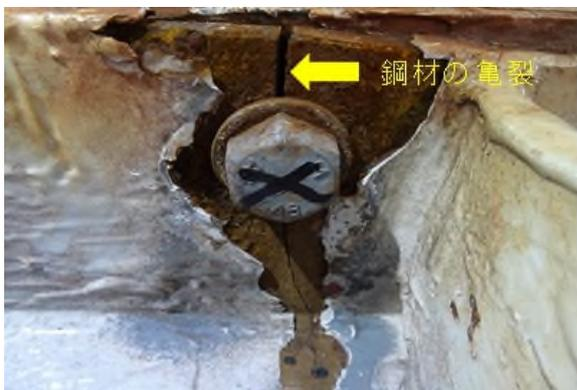
① 伸縮装置の腐食状況 (路面裏側)
