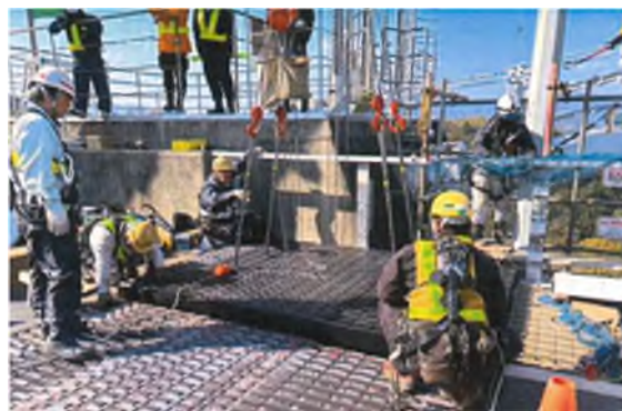
④ 新規大型伸縮装置設置状況
