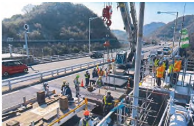
③既設大型伸縮装置撤去状況
