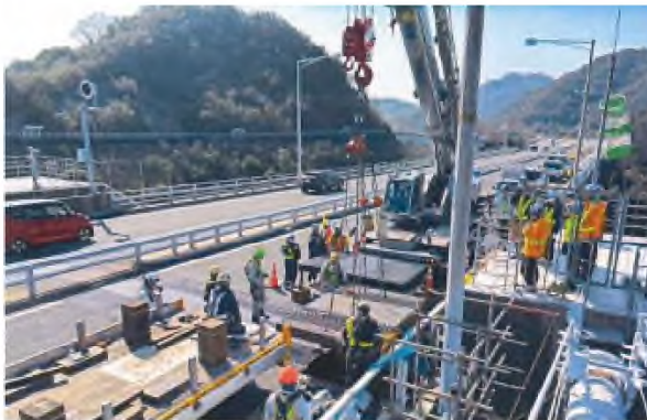
③既設大型伸縮装置撤去状況
