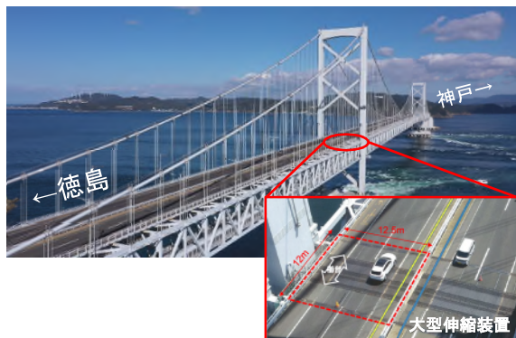
① 大型伸縮装置交換箇所
