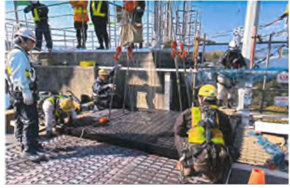
④新規大型伸縮装置設置状況
