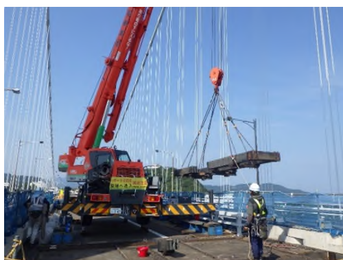
③大型伸縮装置撤去状況
