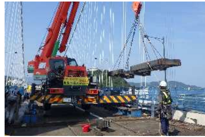
(新)大型伸縮装置の設置作業状況
