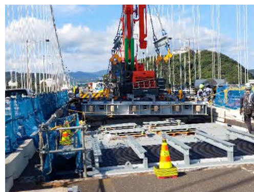
④（新）大型伸縮装置設置作業状況
