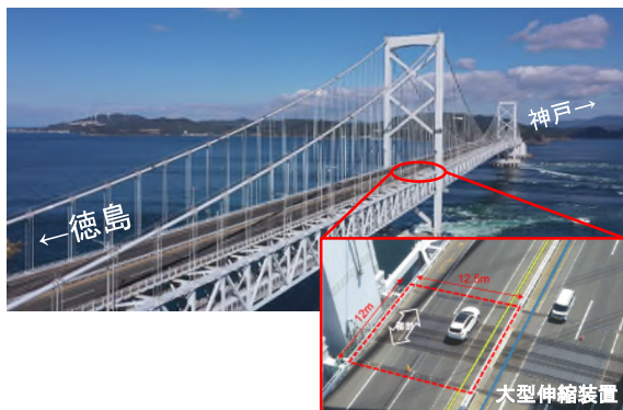
① 大型伸縮装置交換箇所
