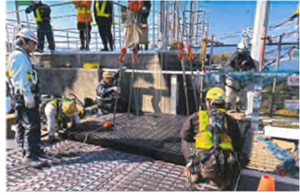
④新規大型伸縮装置設置状況
