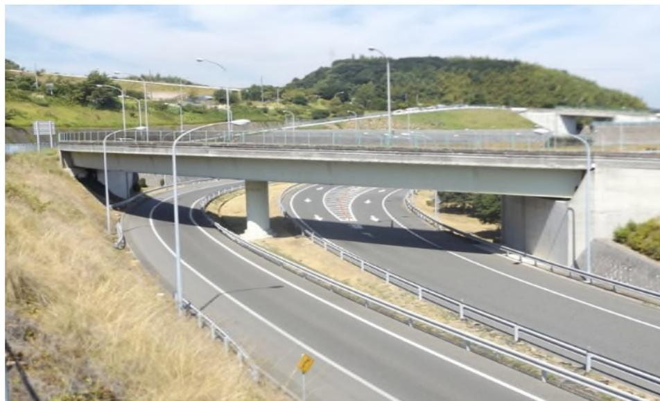
上部工形式： 鋼 2 径間連続非合成箱桁ラーメン橋
