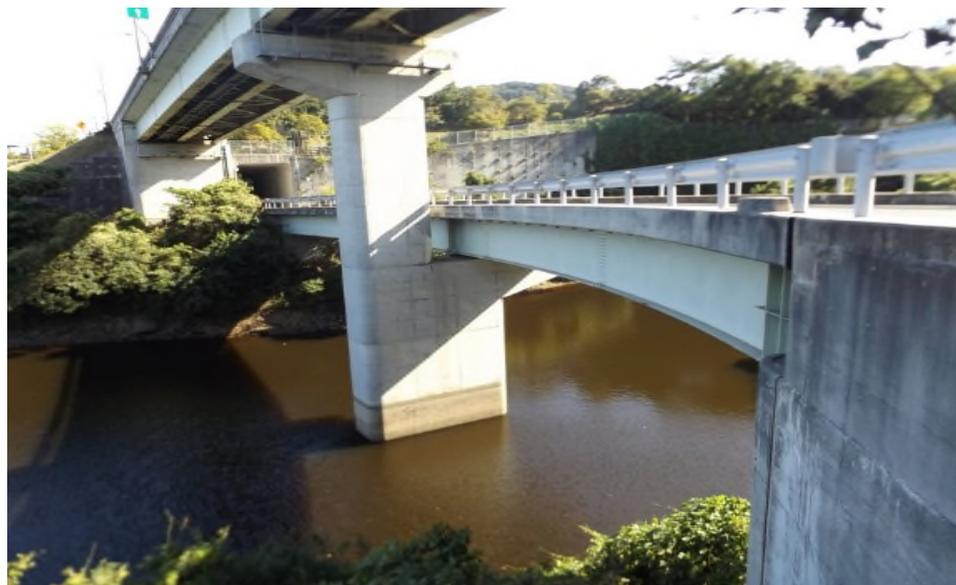
上部工形式： 鋼 2 径間連続非合成鈹桁
