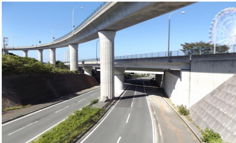
上部工形式： PC 3 径間連続箱桁+PC 4 径間連続箱桁
