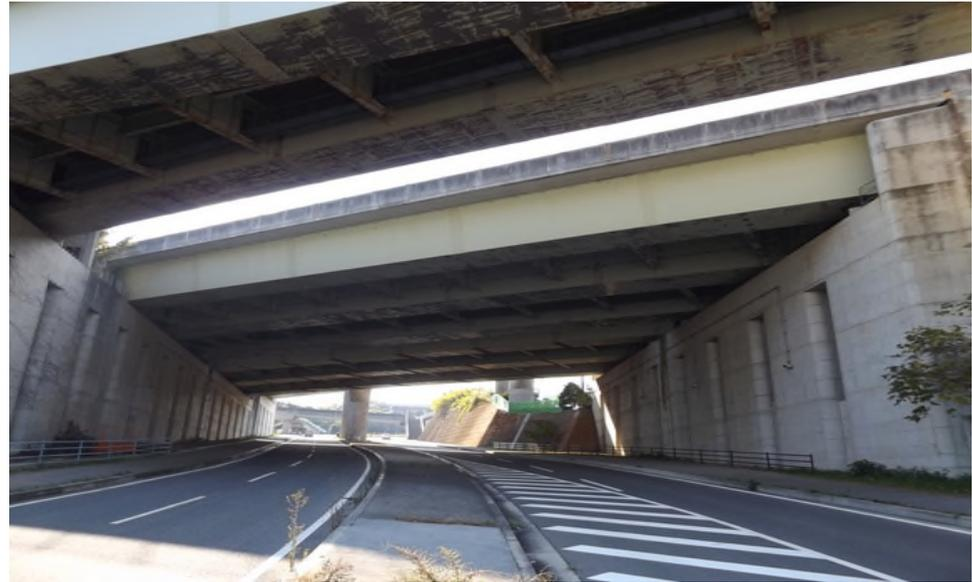
上部工形式： 鋼単純非合成箱桁
