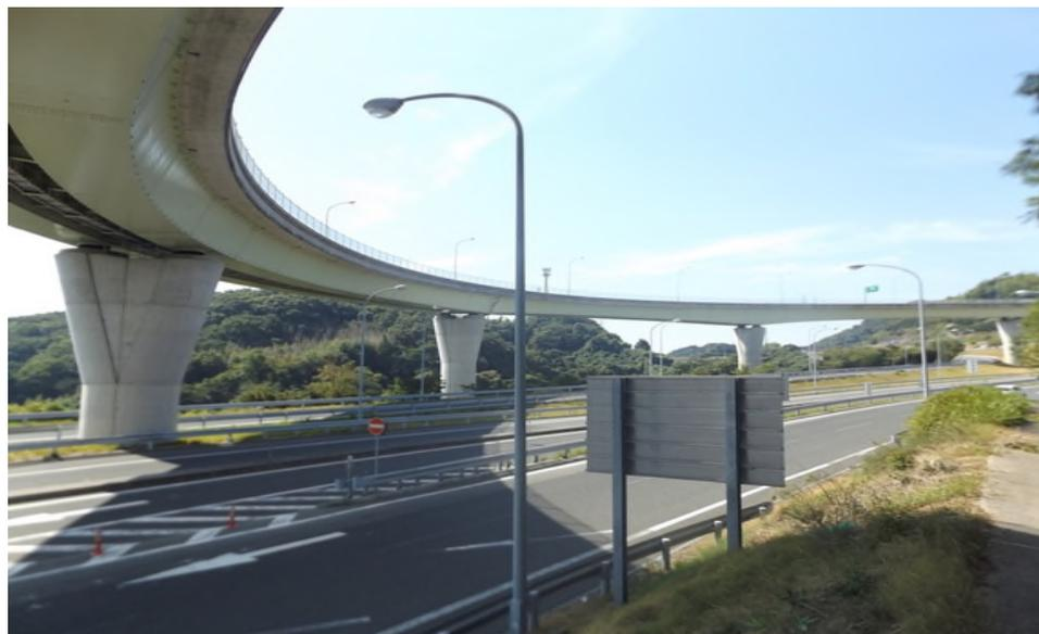
上部工形式： 鋼6径間連続非合成箱桁
