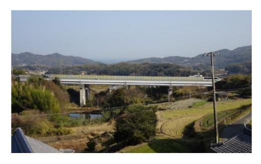
上部工形式: PC4径間連結合成桁
