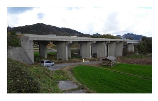
上部工形式: 鋼2径間連続非合成鈑桁+RC5径間連続中空床版
