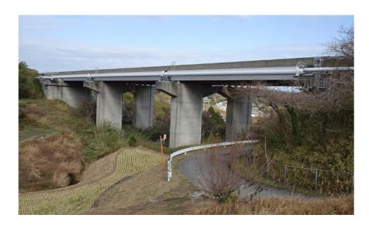
上部工形式: 鋼3径間連続非合成鈑桁
