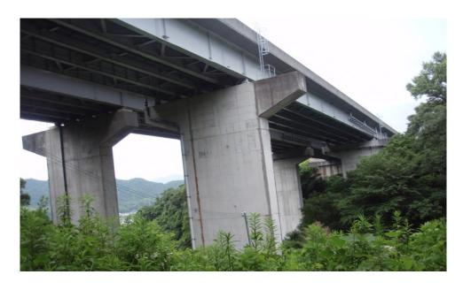
上部工形式: 鋼3径間連続非合成鈑桁 基礎工形式: 直接基礎、場所打ちぐい
