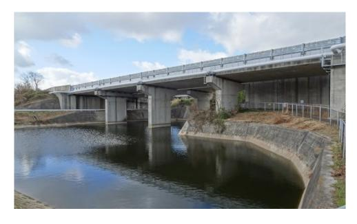
上部工形式: 上り線 RC3径間連続中空床版
