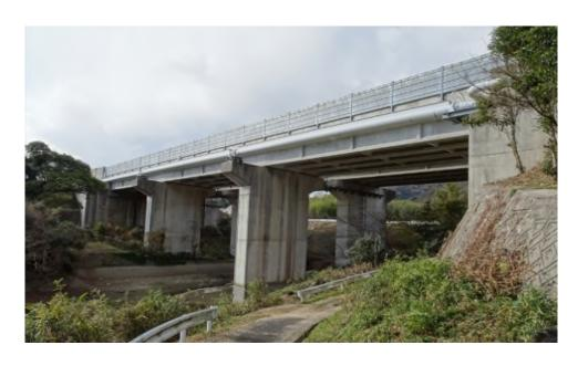
上部工形式: PC3径間連続合成桁 基礎工形式: 直接基礎、場所打ちぐい
