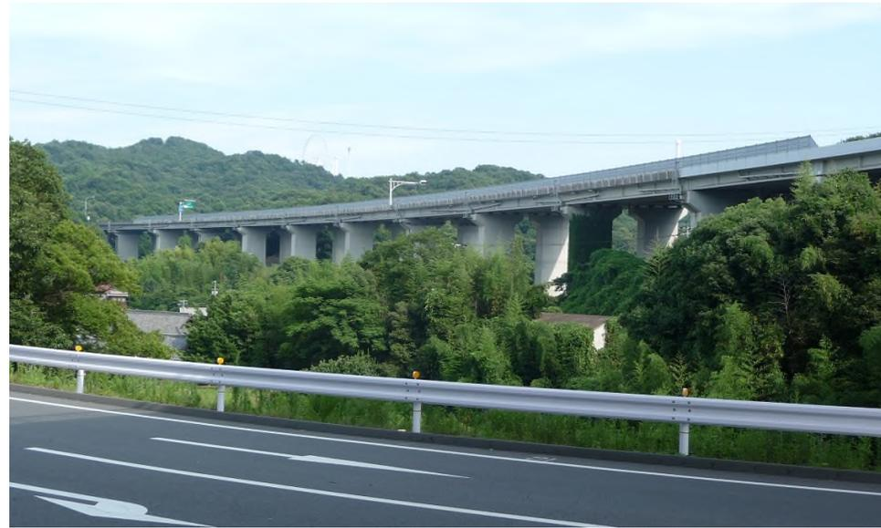
上部工形式： 上り線 PC 2径間連続合成桁+PC 3径間連続合成桁×2
