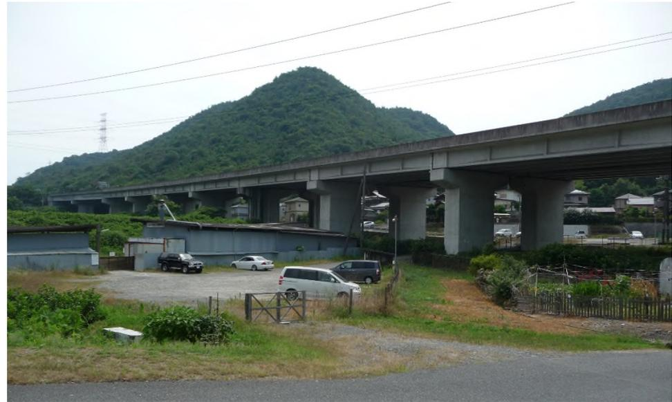
上部工形式： PC 4 径間連続合成桁 × 2 + 鋼 2 径間連続非合成鈹桁
