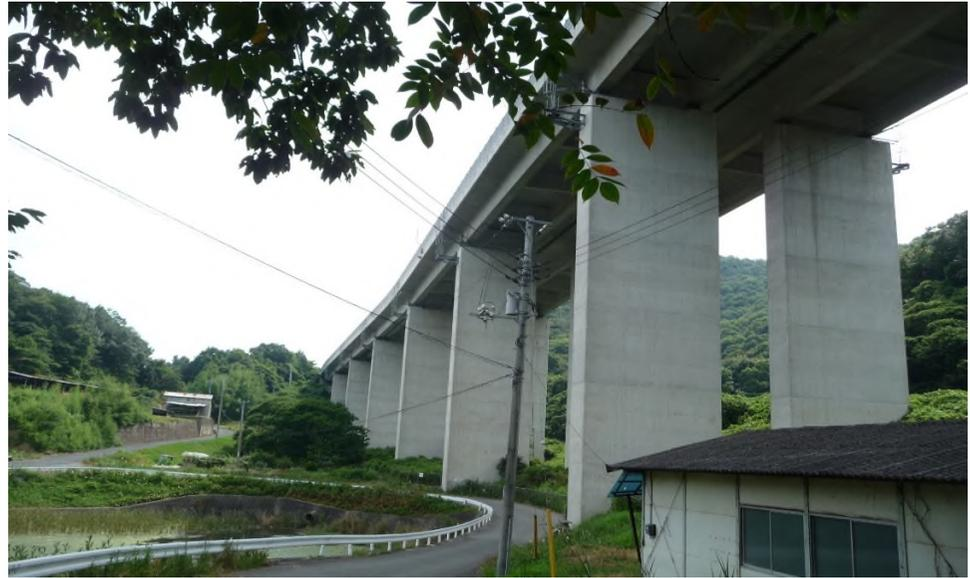
上部工形式： P C 5 径間 2 主版桁 + P C 4 径間 3 主版桁
