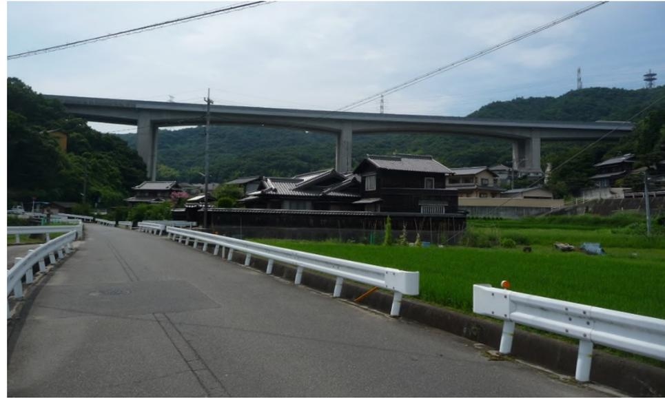
上部工形式： PC 4 径間連続ラーメン箱桁
