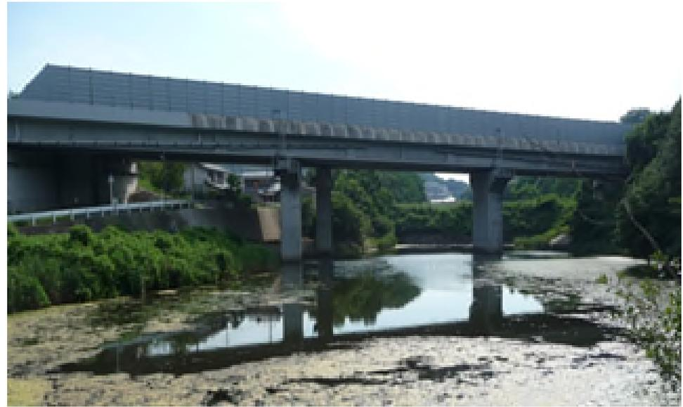
上部工形式： P C 3 径間連続合成桁
