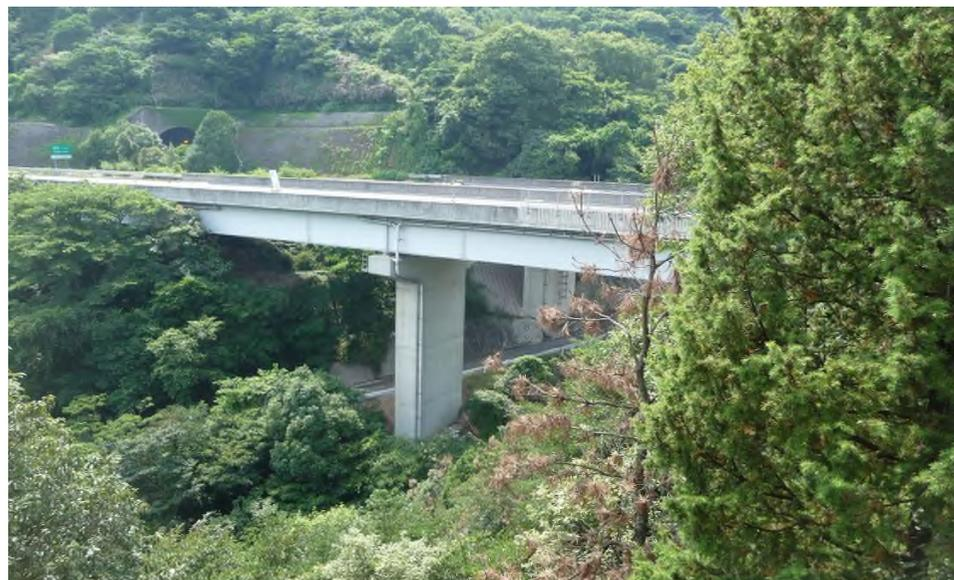
上部工形式： 上り線 鋼単純合成箱桁＋鋼単純非合成鈹桁
