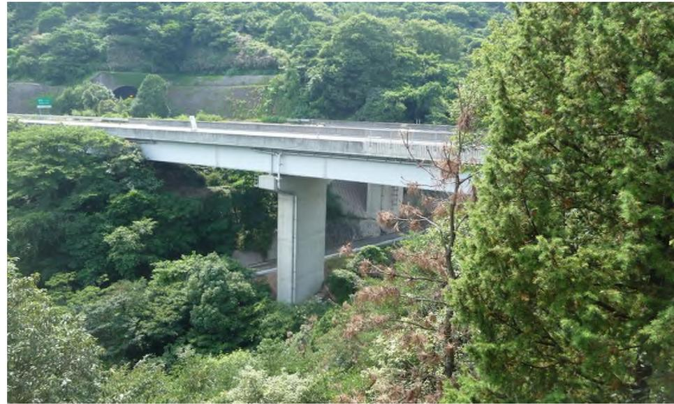
上部工形式： 上り線 鋼4径間連続鋼床版箱桁
