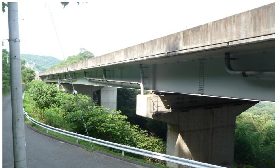
上部工形式： 上り線 鋼3径間連続非合成鈹桁
