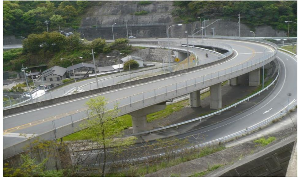
上部工形式： RC 4 径間連続中空床版 + RC 3 径間連続中空床版
