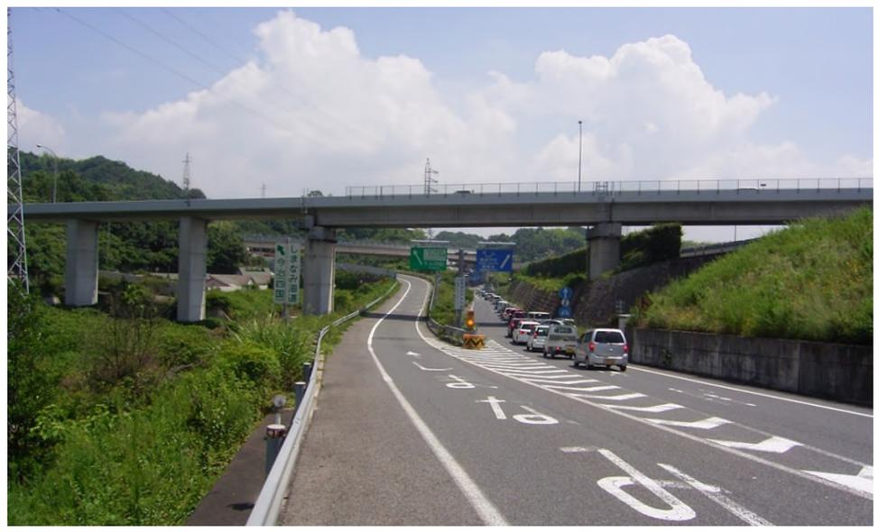
上部工形式： RC 3径間連続中空床版+PC単純合成桁+PC単純T桁
