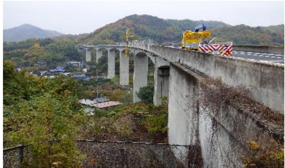
上部工形式： P C 7 径間連続ラーメン箱桁
