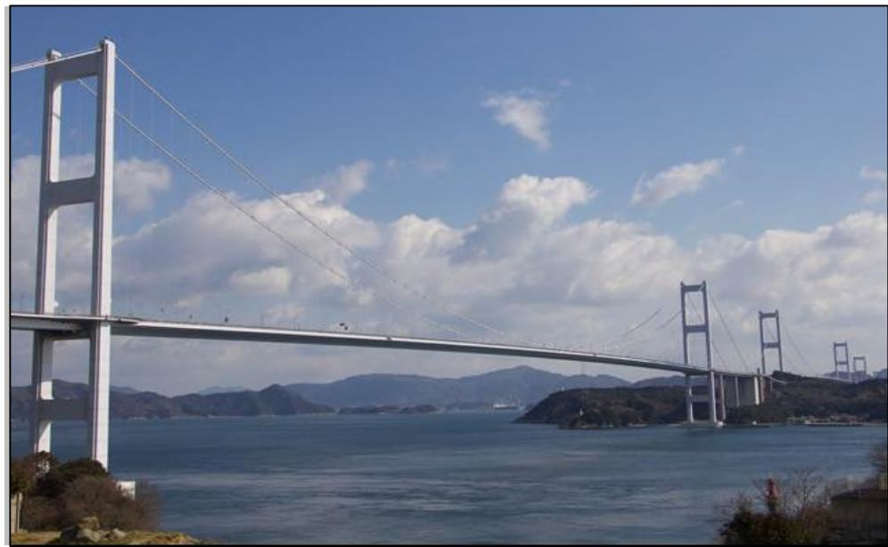
上部工形式：単径間 2 ヒンジ補剛箱桁吊橋
