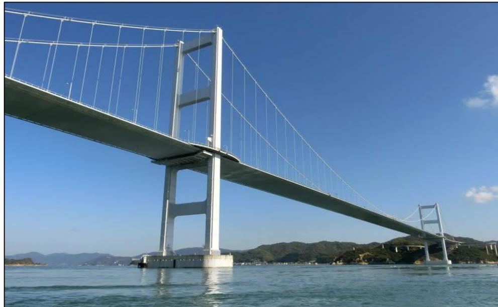
上部工形式：3径間2ヒンジ補剛箱桁吊橋
