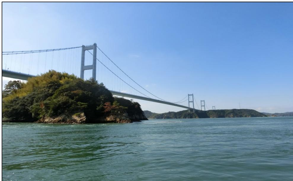
上部工形式：2径間2ヒンジ補剛箱桁吊橋
