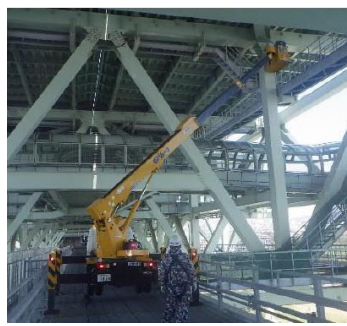
高所作業車による施工例
