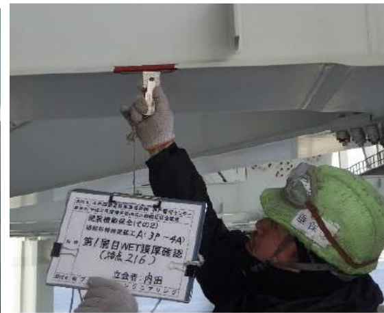
第1層目WET膜厚確認
