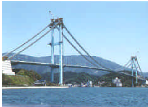
主桁架設完了後の全景 (広島県道路公社提供 4月撮影)
