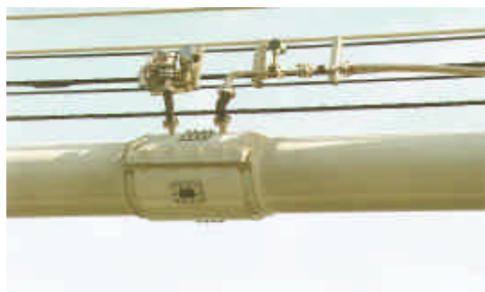
来島海峡大橋のケーブルと送気バンド New system at the Kurushima-Kaikyo Bridge
