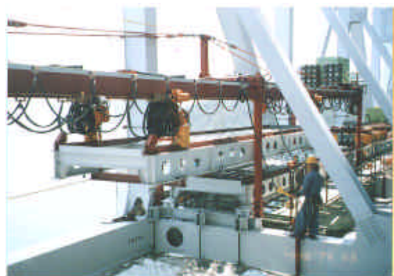
連絡通路の架設状況
