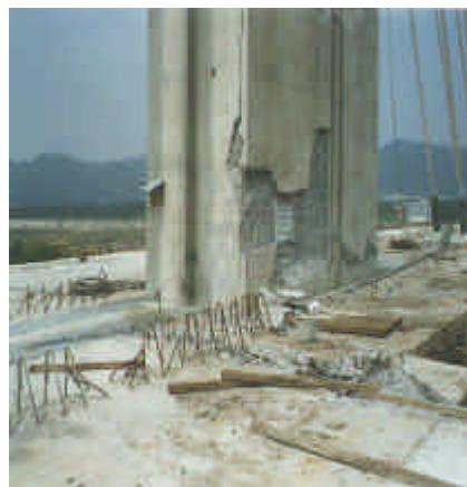
主塔基部 Bottom of main tower
