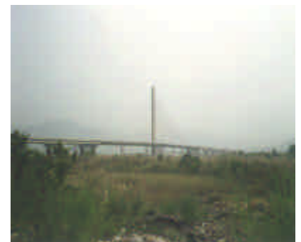
集鹿大橋 Ji Ji Da Bridge
