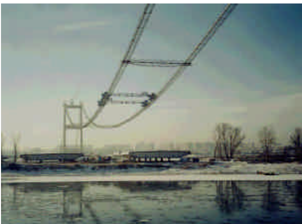
イルティシュ河橋梁 Irtysh River Bridge
