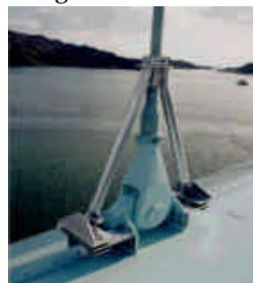
ハンガーロープの制振装置 Damping devices for suspenders
