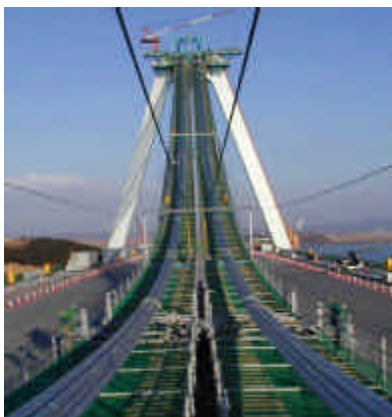
ケーブル架設状況 Installation of main cable
