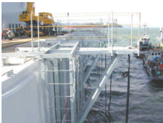
電着設備の設置
