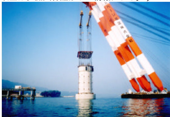
据付け中の防衝工（大阪府土地開発公社提供）
