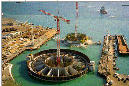
ドックによる施工状況
