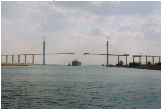
桁架設が進むスエズ運河架橋（撮影；金澤克義氏）
