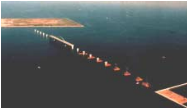
建設中の新北九州空港連絡橋
