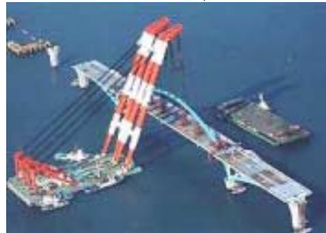
中央アーチ部の架設
