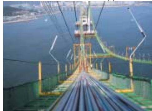
ケーブル架設状況 (Installation of main cable)
