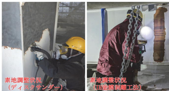
写真-2 素地調整状況
