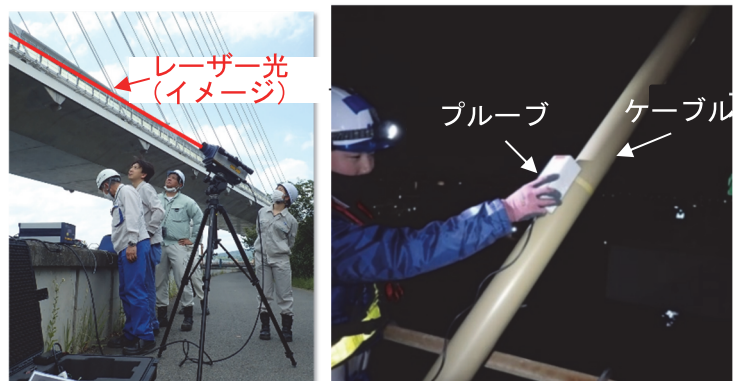
写真-4 レーザードップラー振動計による張力測定(左) ECT法によるケーブル素線の腐食調査(右)
