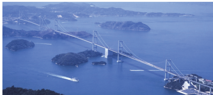
写真-1 来島海峡大橋 Photo 1 Kurushima-Kaikyo Bridges
