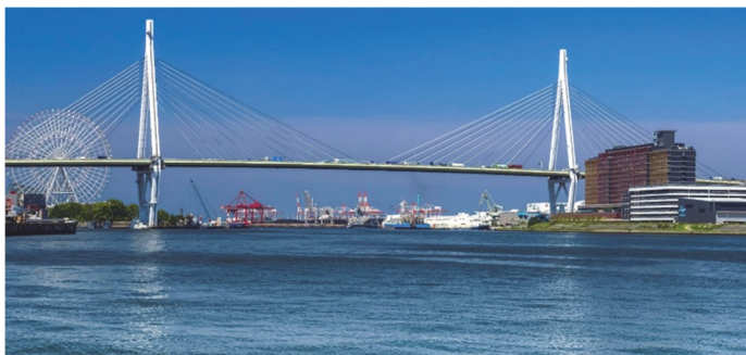
写真-3 天保山大橋 Photo 3 Tempohzan Bridge
