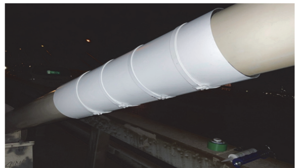
写真-8 補修完了（ステンレスカバー設置状況） Photo 8 Installation of Stainless-Steel Covers
