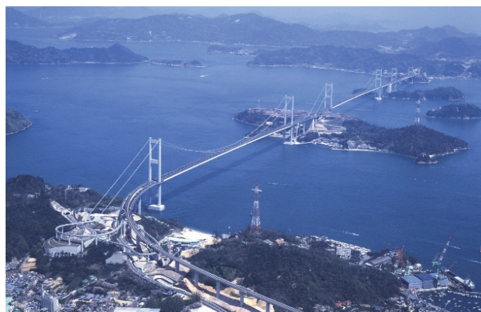
写真-5 来島海峡大橋 Photo 5 Kurushima-Kaikyo Bridges
