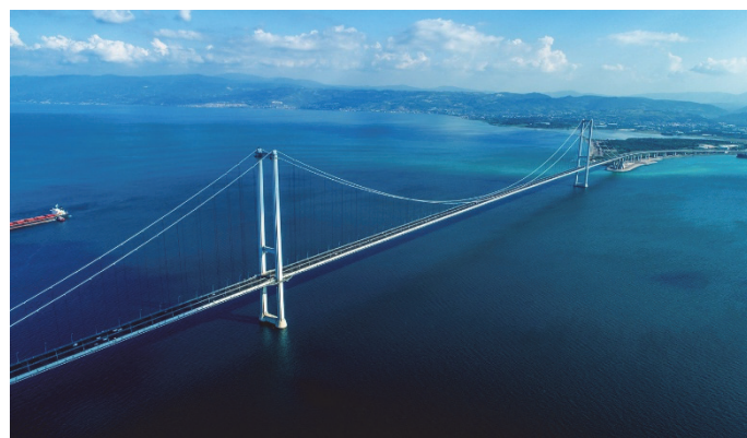
写真-6 オスマン・ガジ橋 Photo 6 Osmangazi Bridge
