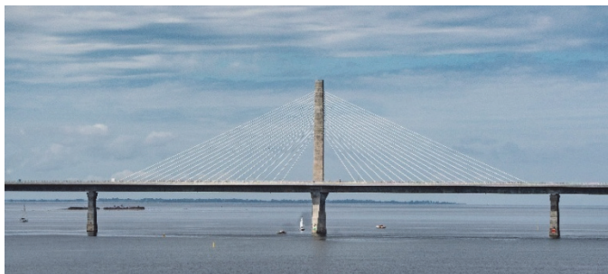
写真-7 橋梁全景
