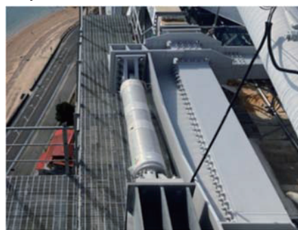
写真-1 粘性ダンパー設置状況 Photo 1 Viscous damper installation
