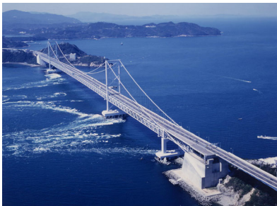
写真-1 塩害環境下にある本四連絡橋
