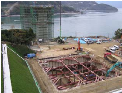
写真-4 4A 施工状況
