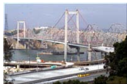
写真-6 新カルキネツ橋
