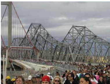
写真-5 開通の状況
