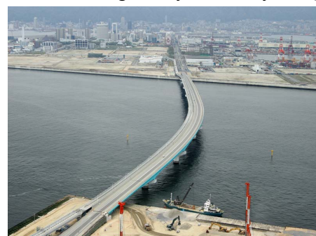
写真-3 神戸スカイブリッジ (Photo.3 Kobe Sky Bridge)
