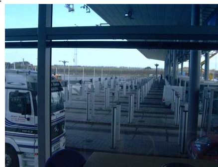
写真-5 22レーンある料金所風景 (Photo.5 22 lanes of Toll Plaza)
