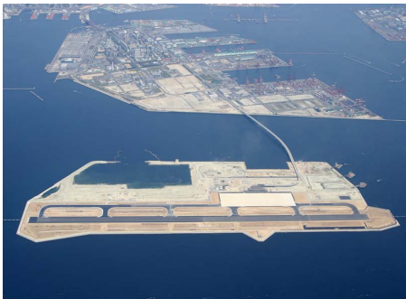
写真-2 神戸空港(マリンエア)全景 (Photo.2 Kobe Airport "Marine Air")
