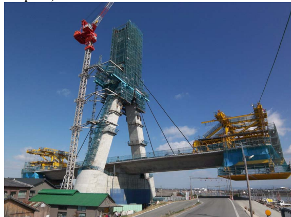
写真-5 矢部川橋の超大型ワーゲン(P2 主塔側) (Photo.5 Extra large moving platform(P2 Tower side))
