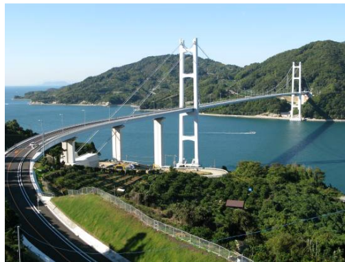
写真-2 豊島大橋全景
