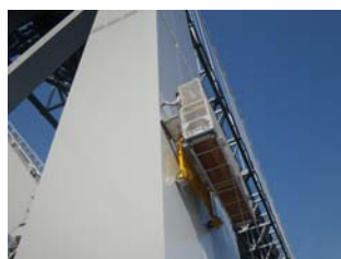
写真-2 磁石車輪ゴンドラ (Photo.2 Magnetic Wheel Gondola)
