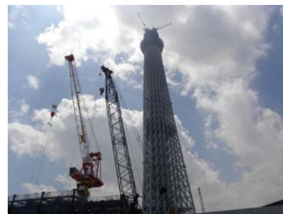
写真-4 東京スカイツリーの建設状況(5月末) (Photo-4 Construction stage (As of the end of May))
