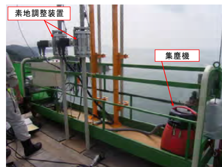
写真-2 素地調整装置ゴンドラ取付状況
