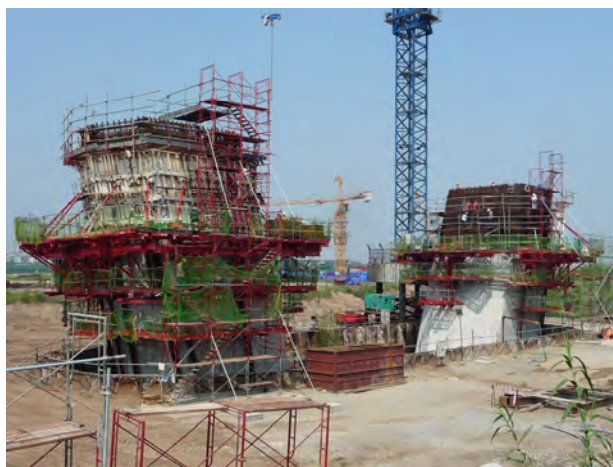
写真-6 P14 パイロン工事中
