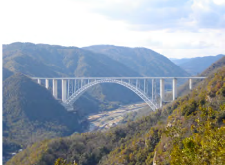
写真-2 広島空港大橋
