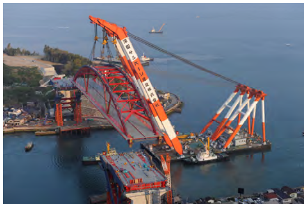
写真-4 大ブロック一括架設状況
