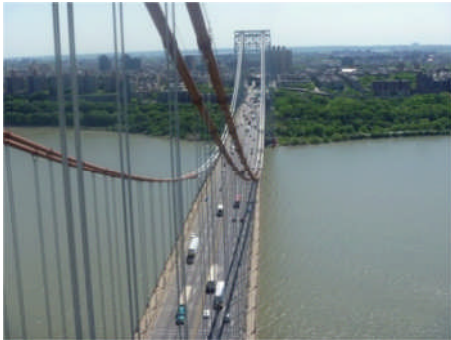
写真-9 ジョージ・ワシントン橋 Photo.9 George Washington Br. at technical Visit
