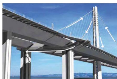
写真-8 自碇式吊橋（完成予想図） Photo.8 Self-Anchored Bridge (Conception drawing)
