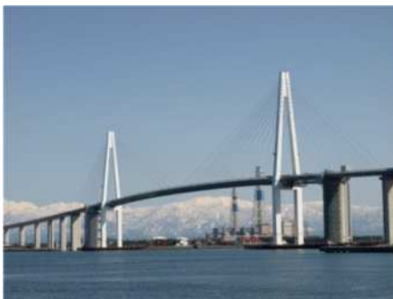
写真-3 新湊大橋の全景 Photo.3 Shin-Minato Bridge
