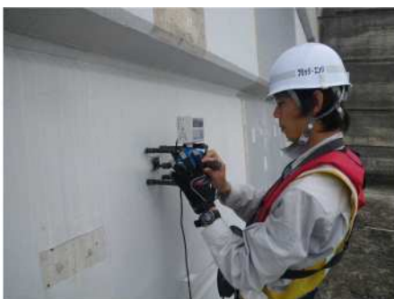
写真-1 塗膜の付着力試験
