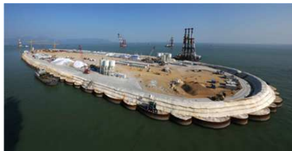
写真-5 施工中の人工島
