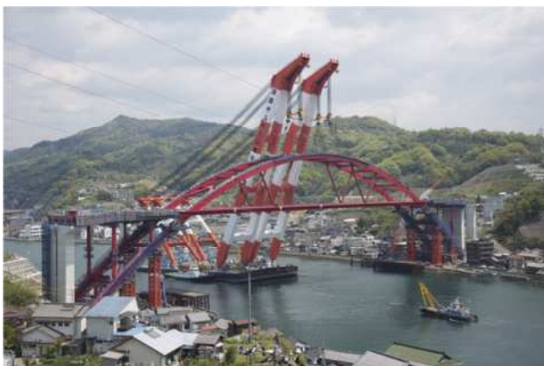
写真-3 大ブロック架設 Photo.3 Large block election
