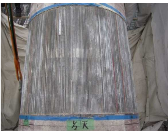
写真-3 ケーブル開放調査の状況 Photo.3 Condition of main cable
