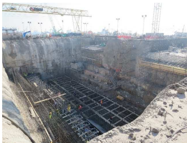
写真-7 北側アンカレイジコンクリート打設 Photo.7 Concreting of North Anchorage
