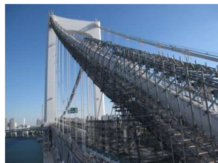
写真-5 工事用足場 Photo.5 Scaffolding
