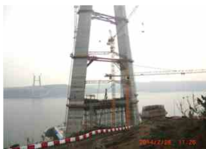
写真-4 第3ボスポラス橋主塔工事 Photo 4 3rd. Bosphorus Bridge
