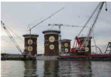
写真-3 イズミット湾横断橋主塔基礎 のウェットドックでの構築 Photo 3 Tower Foundations of Izmit Bay Crossing
