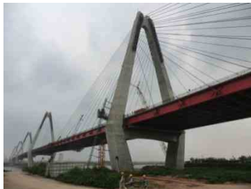
写真-2 全体工事状況【北側P16より撮影】 Photo 2 General View of Construction Site from North side P16
