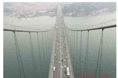
写真-5 第1ボスポラス橋（斜めハン ガーを垂直ハンガーに交換予定） Photo 5 1st. Bosphorus Bridge
