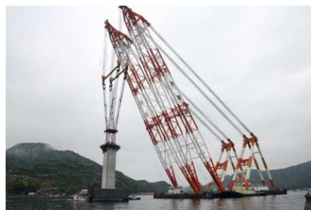
写真-3 橋脚据付状況
