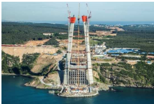
写真-4 主塔の建設状況 Photo 4 Construction of a tower
