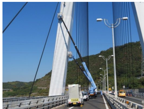
写真-2 高所作業車(27m級)2台使用
