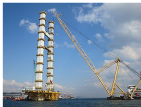
写真-6 ブロック架設
