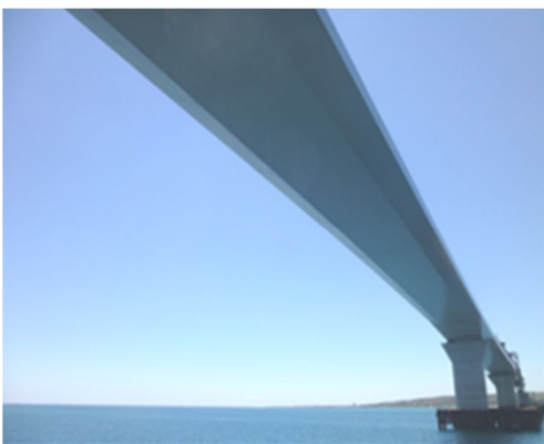
写真-4 主航路部の中央径間
